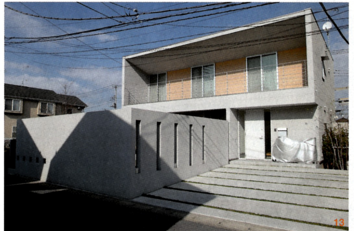
13. 夏の日差しをさえぎり、冬は採光を妨げない深めの軒。屋根材と断熱材の間には通気層を設け、夏は屋根で熱せられた空気を軒先から排出する仕組みとなっている
