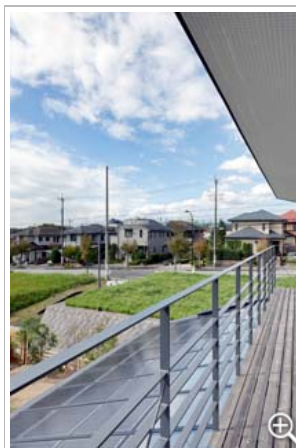
太陽光発電パネルは容量4kWで、ソーラーシステム・発電・暖房・給湯を組み合わせた。長期優良住宅の断熱性能を持つY邸は暖房機器使用量も少なく、電気料金は消費よりも生産が上回る。ガスも給湯がほぼ自前でまかなえるため「夏場は月1500円くらいです」
